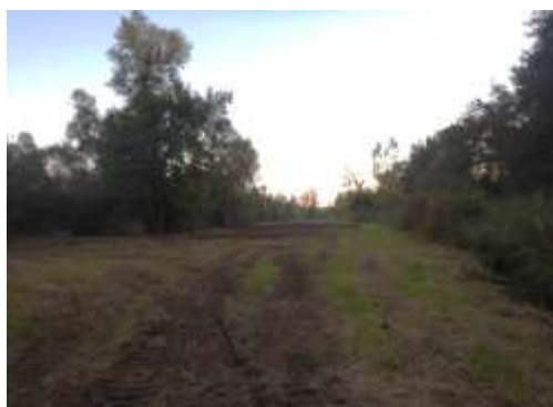
Travaux en septembre
